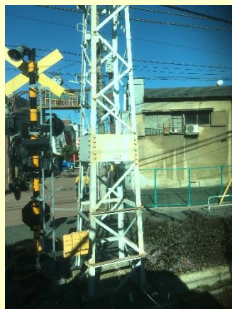
【沿線の架線柱】
